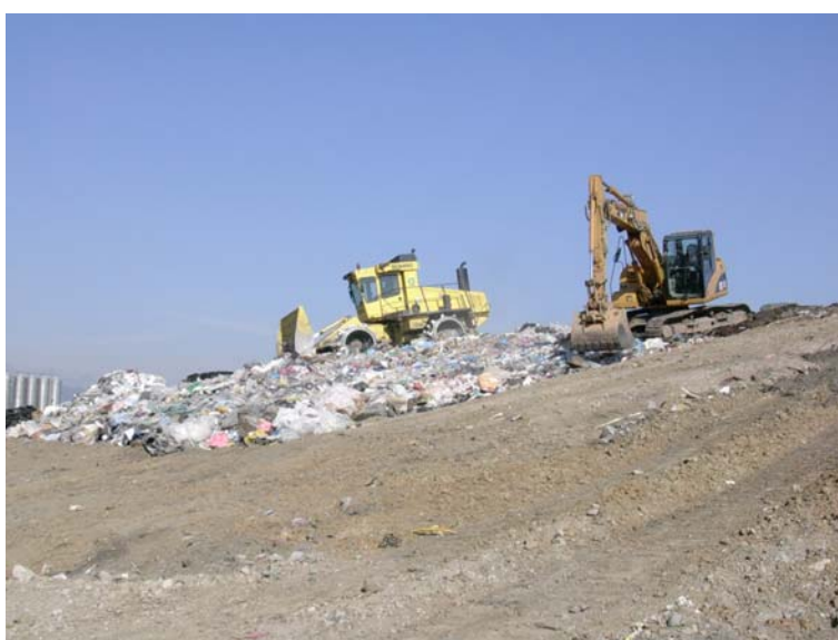
Foto1: stesura e compattazione dei rifiuti sul fronte di scarico
