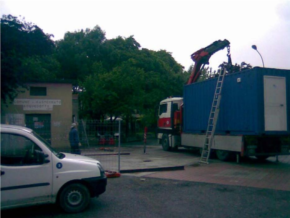
Foto 6. Operazioni di scarico dell'impianto ad osmosi inversa
