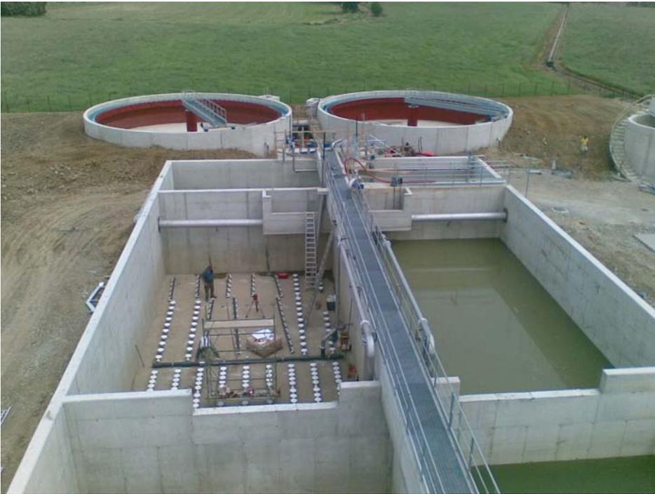
Foto 10. Vista dall'alto delle due linee di processo biologico durante i lavori di posa dell'impianto di insufflazione dell'aria.
