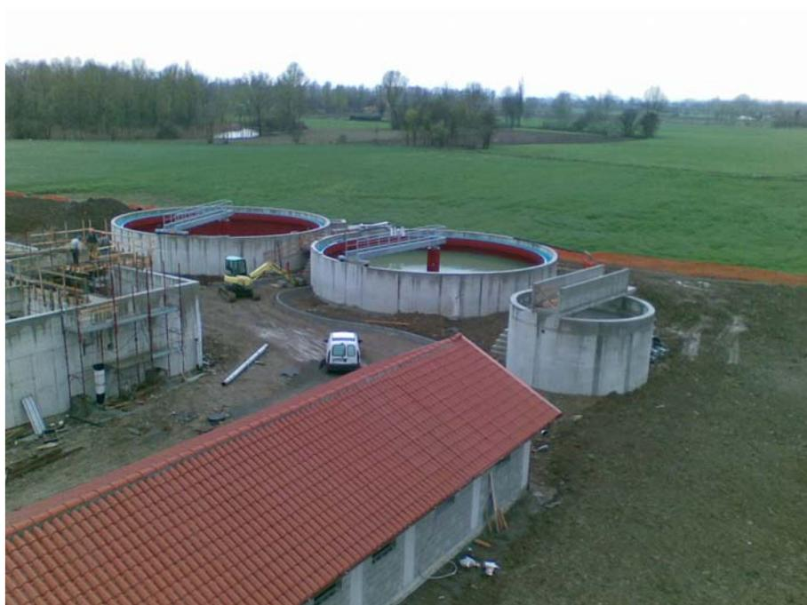
Foto 9. le due linee di sedimentazione finale e il locale tecnico con tetto a doppia falda e copertura in coppi
