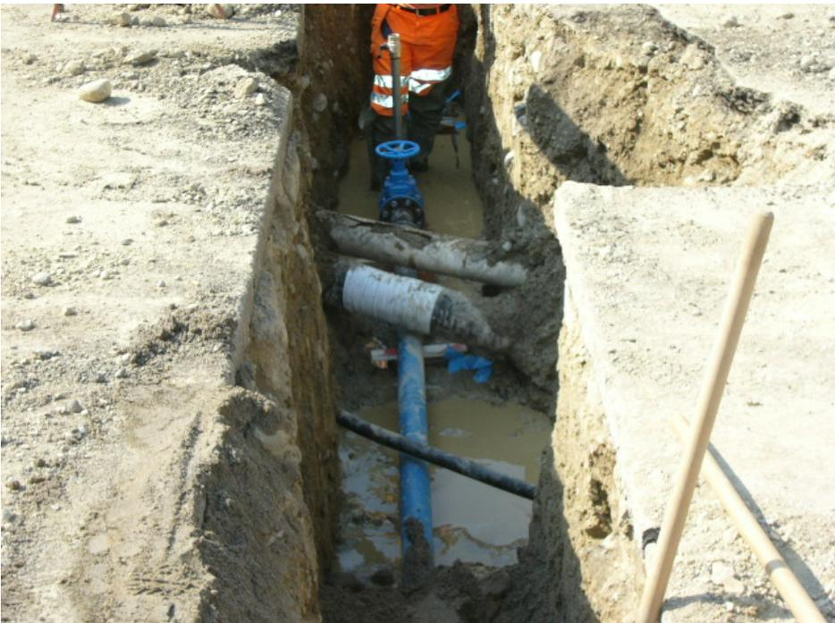
Foto 2 – particolare di attraversamento tubazione ad altri sottoservizi.
