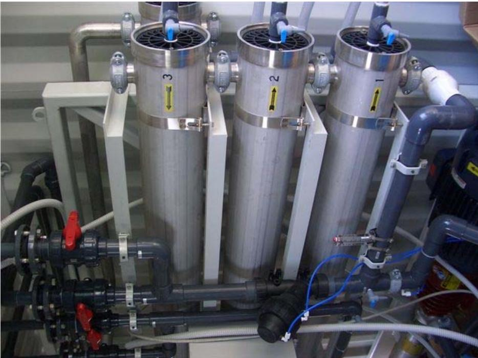
Foto 7. particolare delle membrane
