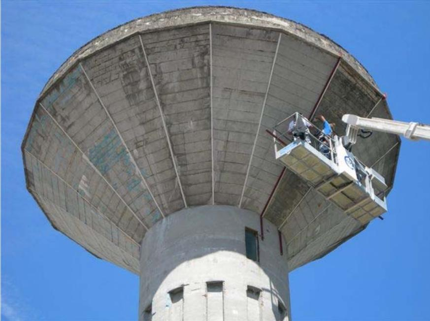
Foto 3. lavori preliminari di pulizia e raschiatura delle pareti
