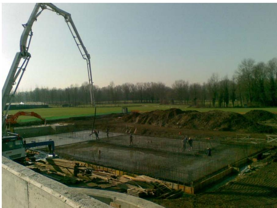
Foto 8. il getto della platea delle vasche di nitrificazione e denitrificazione
