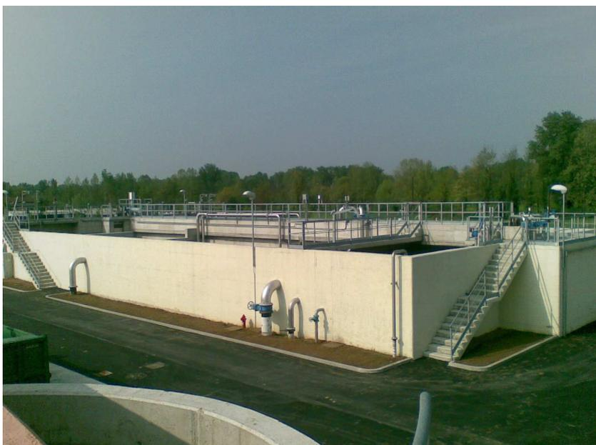
Foto 4. Vista delle due linee di pre-denitrificazione, nitrificazione e stabilizzazione dei fanghi
