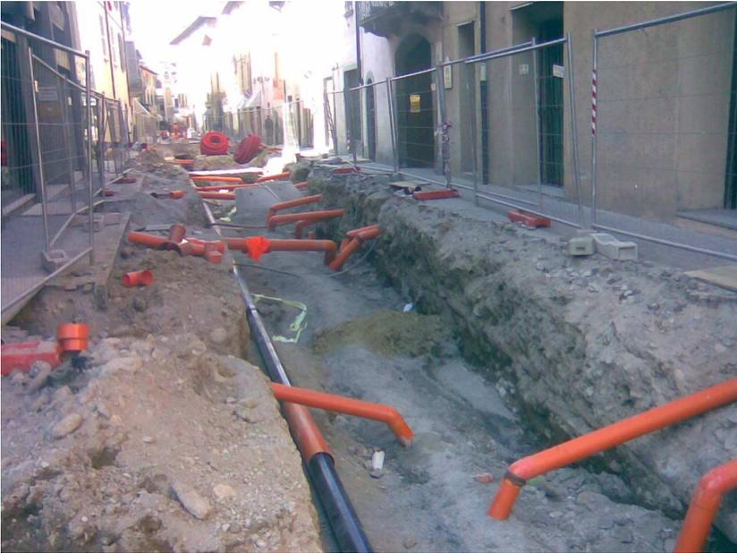
Foto 1 – Rifacimento rete acquedotto Iseo Via Mirolte, eseguito contestualmente al lavoro di rifacimento rete fognaria e riqualificazione pavimentazione di pregio da parte dell'Amministrazione Comunale
