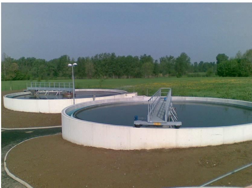
Foto 9. Vista delle due linee di sedimentazione finale
