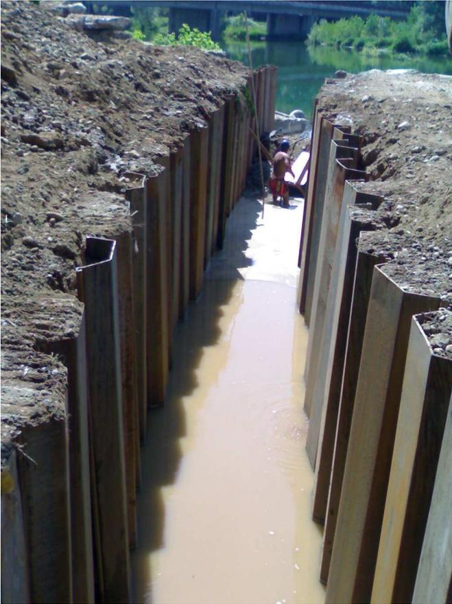
Posa della tubazione di scarico in acqua con protezione di palancole
