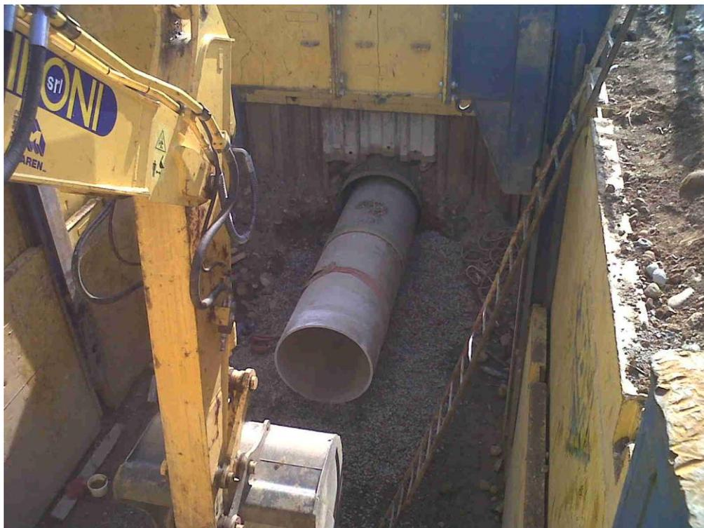
Foto 2 – giugno 2011 – attraversamento con spingi tubo strada provinciale SS55
