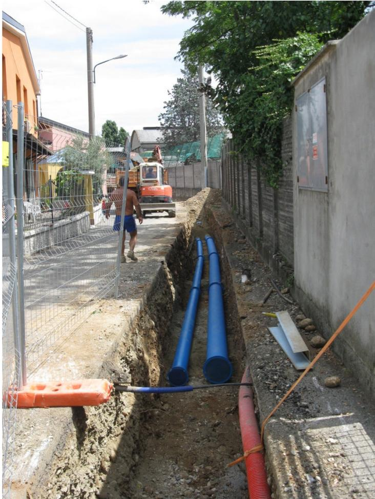
Foto 2 – cantiere via Molino collettore in ghisa
