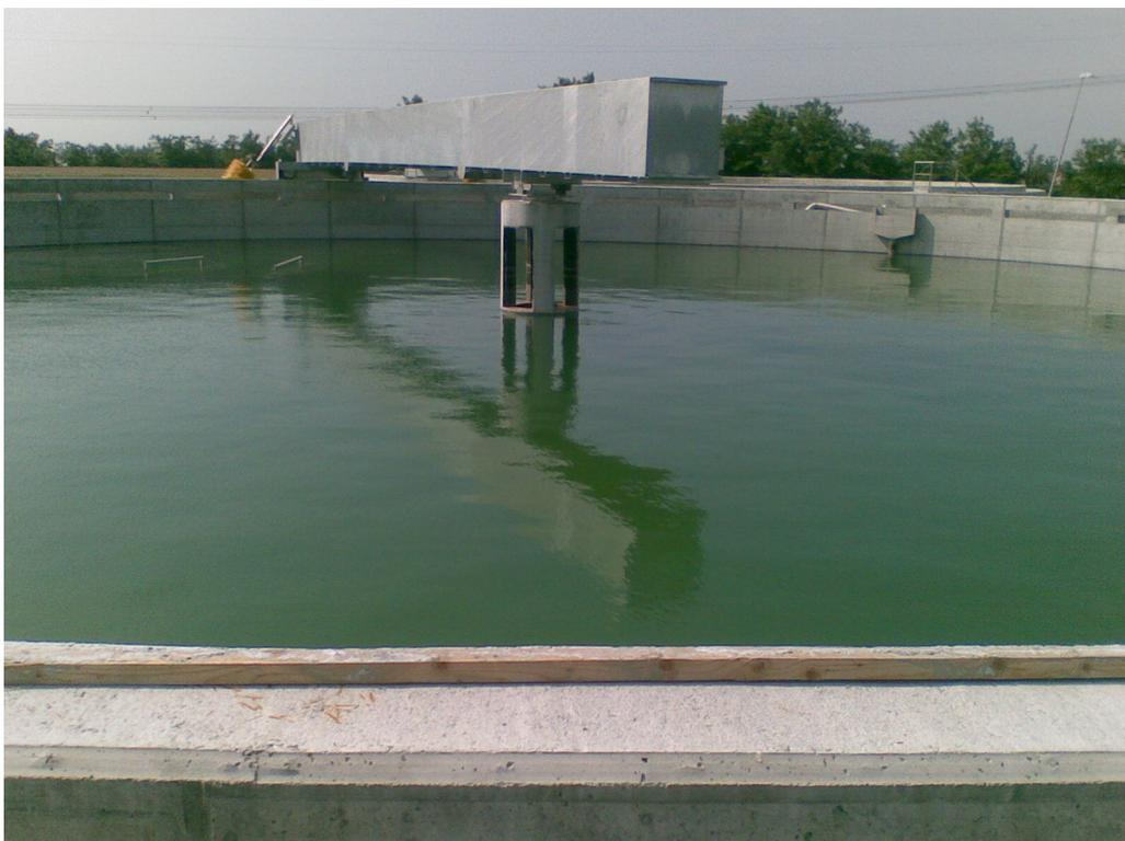
Foto 3 – giugno 2012 – sedimentatori finali – prove tenuta idraulica
