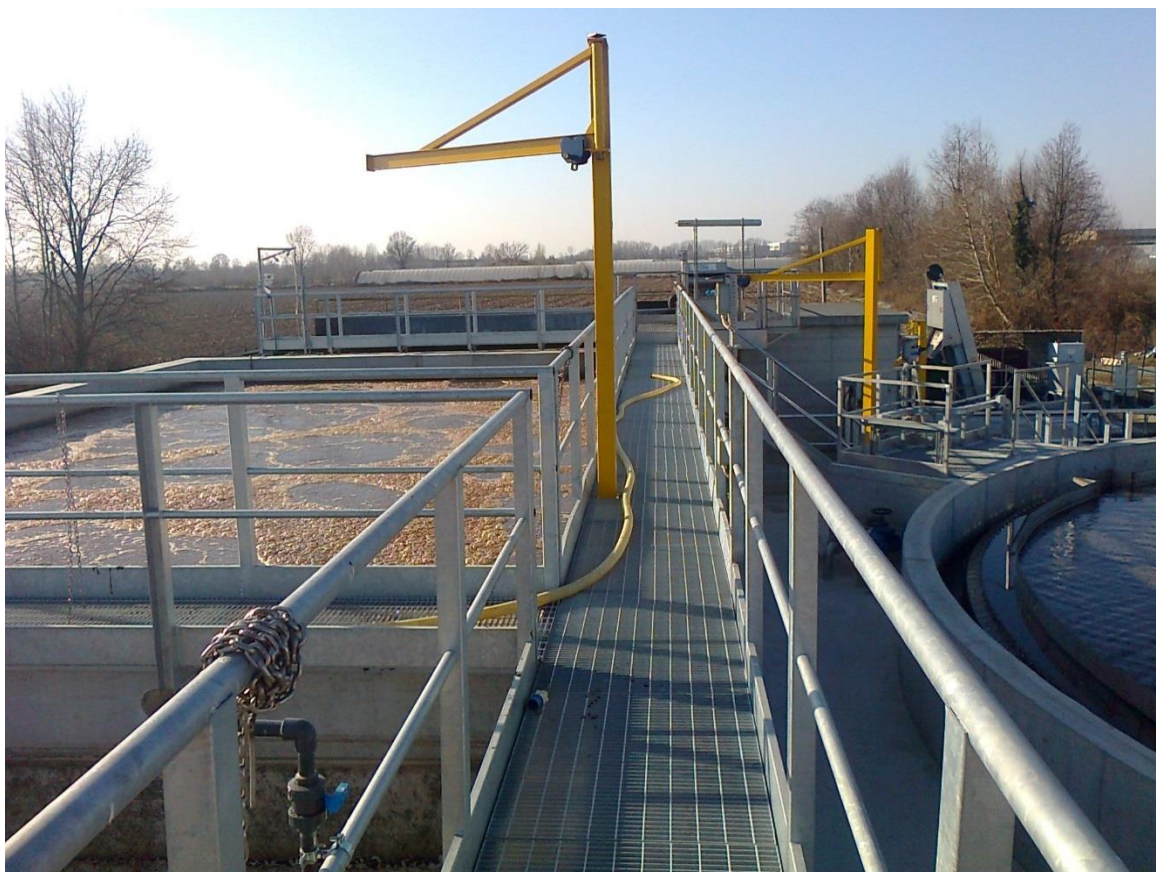
10.3 – Dicembre 2016: Ampliamento depuratore impianto, messa a regime processo depurativo
