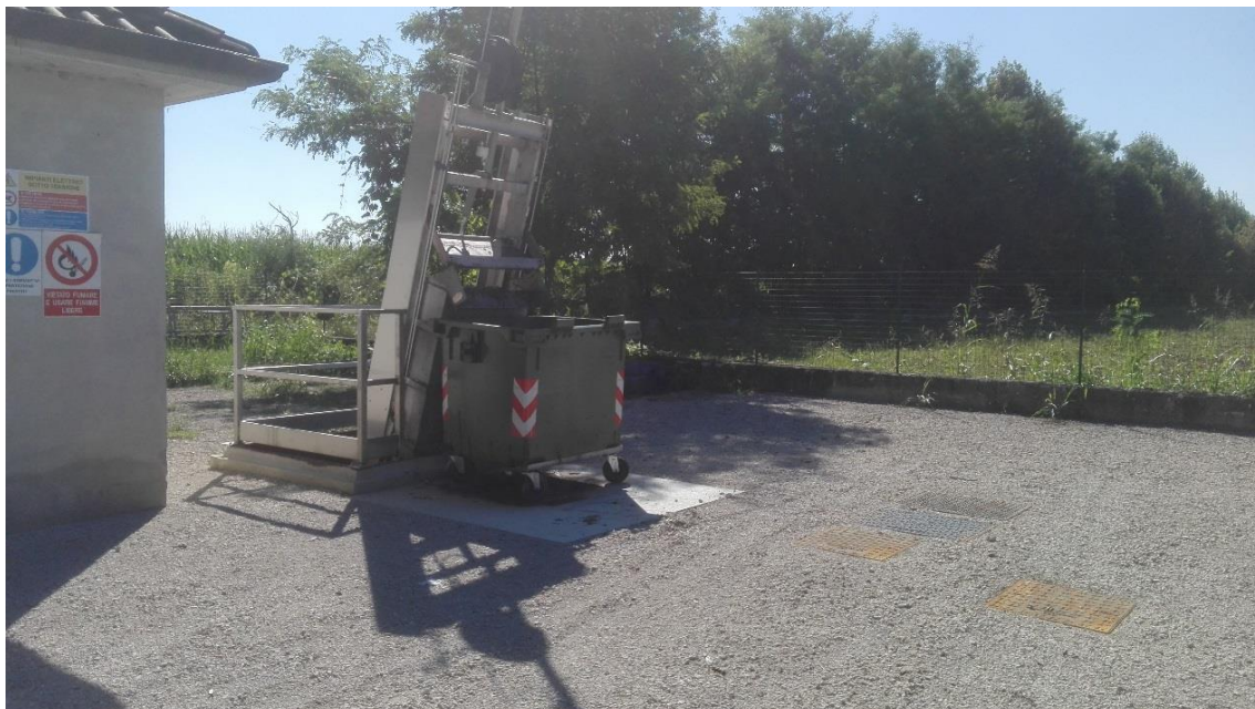
10.1 – settembre 2016: Area ex-depuratore Motella a fine lavori dopo intervento di demolizione e conversione ad impianto di sollevamento
