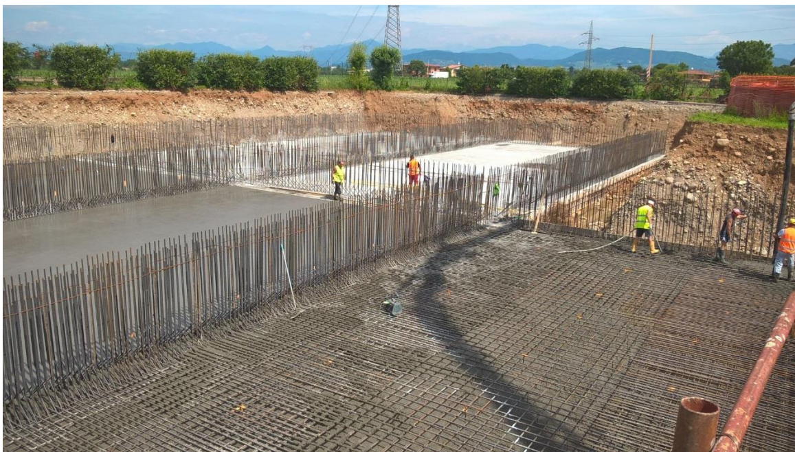
10.2 – giugno 2016: Ampliamento depuratore Palazzolo, operazioni di getto platea nuovo comparto biologico
